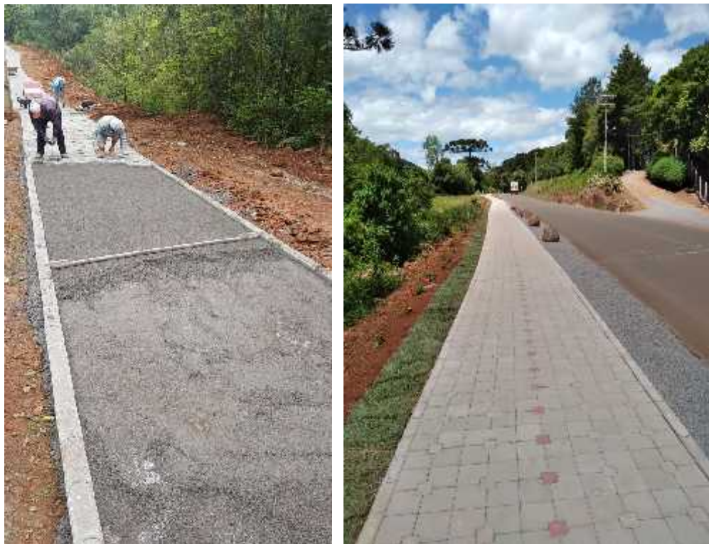
Modelo de guias utilizados na pavimentação e canteiros.
